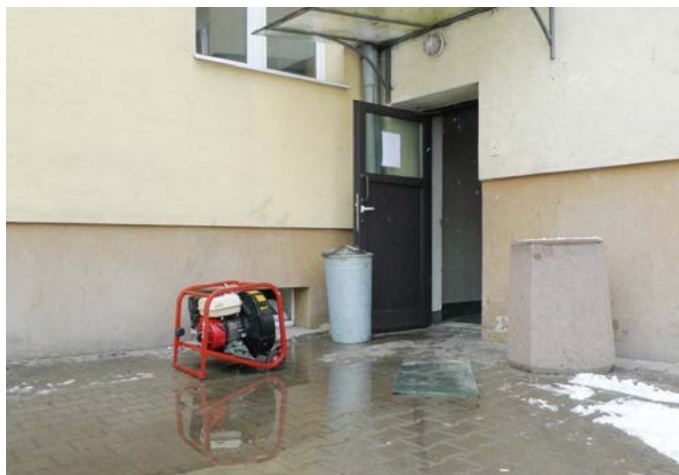
Figure 8. Trashcan blocking the possibility of closing the aeration opening Rycina 8. Kosz na śmieci blokujący możliwość zamknięcia otworu napowietrzającego Source: Own elaboration. Źródło: Opracowanie własne.
