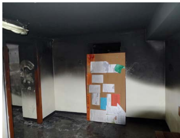
Figure 16. Use of a school board to achieve an overpressure effect in a part of a building during zonal smoke extraction Rycina 16. Wykorzystanie tablicy szkolnej do uzyskania efektu nadciśnienia w części obiektu w trakcie oddymiania strefowego
