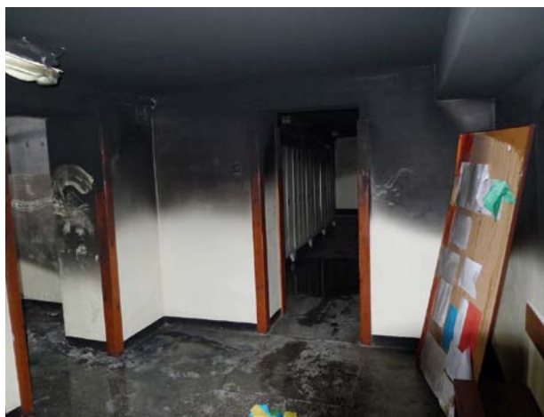
Figure 16. Use of a school board to achieve an overpressure effect in a part of a building during zonal smoke extraction Rycina 16. Wykorzystanie tablicy szkolnej do uzyskania efektu nadciśnienia w części obiektu w trakcie oddymiania strefowego
