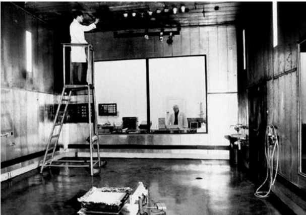
Rycina 3. Komora testowa do badań czujek Źródło: Archiwum CNBOP-PIB.
