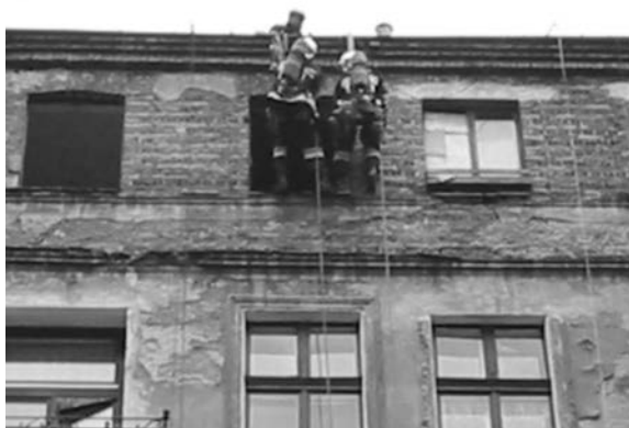
Fot. 8 Wycinanie krat na 4 piętrze budynku.
