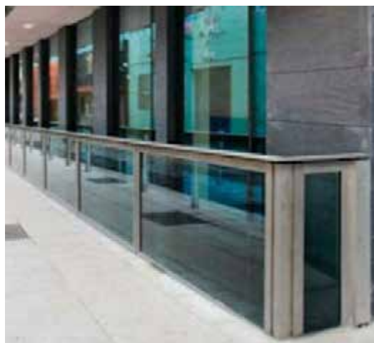
Ryc. 13. Szklane bariery przeciwpowodziowe [22] Fig. 13. Glass flood barriers [22]
