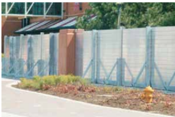
Ryc. 9. Płoty przeciwpowodziowe [19] Fig. 9. Flood fence [19]
