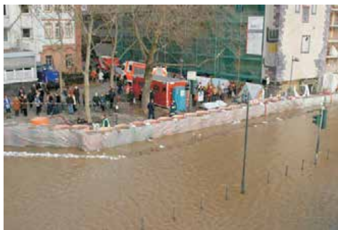
Ryc. 8. Zapory pionowe chroniące Frankfurt przed zalaniem w 2011 roku [18]
