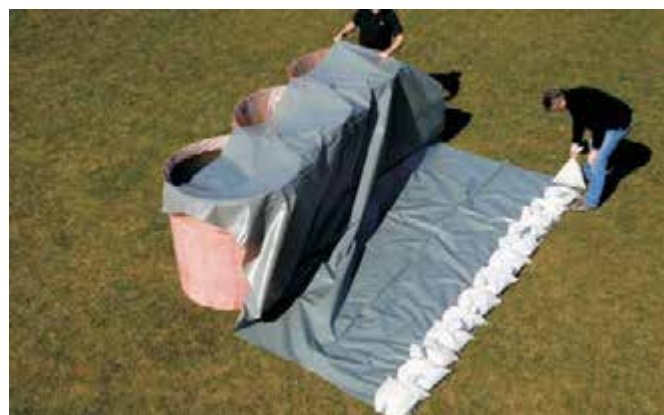
Ryc. 7. Zabezpieczenie zapór od strony napierającej wody [18]
