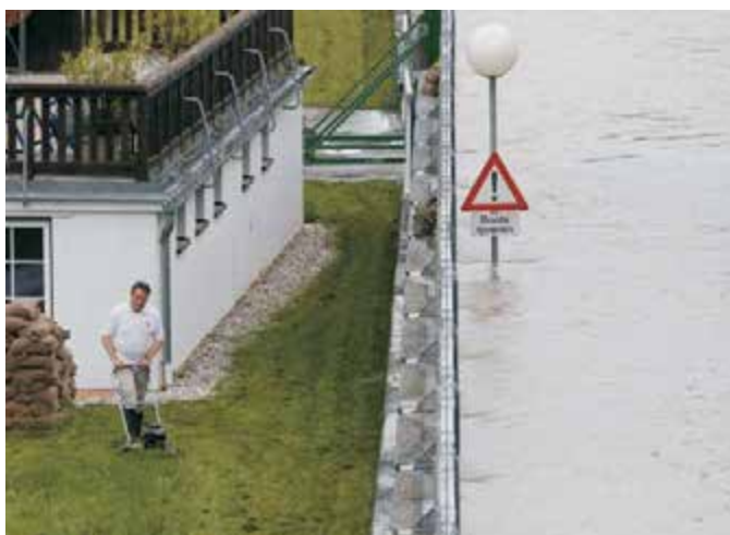
Ryc. 11. Wykorzystanie płotów przeciwpowodziowych podczas powodzi w czerwcu 2013 roku w Austrii [20] Fig. 11. Application of flood fence – flooding in June 2013 in Austria [20]
