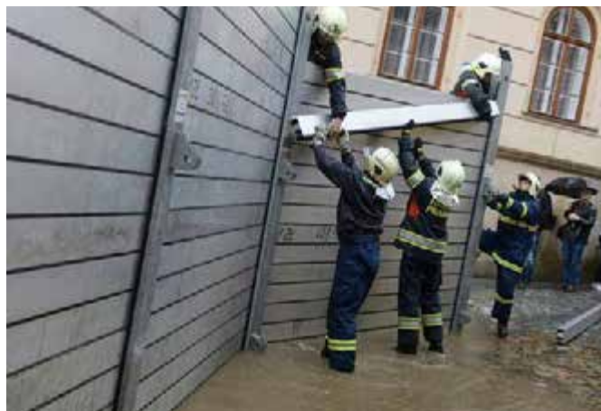
Ryc. 12. Płoty przeciwpowodziowe ustawiane w czeskiej Pradze podczas powodzi w czerwcu 2013 roku [21] Fig. 12. Flood fences erected during Prague flooding in June 2013 [21]
