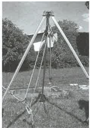
Fot. 5. Budowa układów wyciągowych poza cembrowią studni
