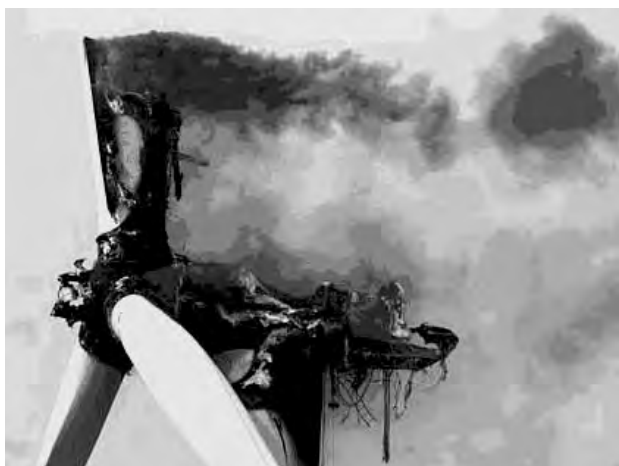
Ryc. 2. Pożar elektrowni wiatrowej (źródło: http://www.british-gazette.co.uk/wp-content/uploads/2010/09/Burnt_Out_Wind_Turbine.jpg )
