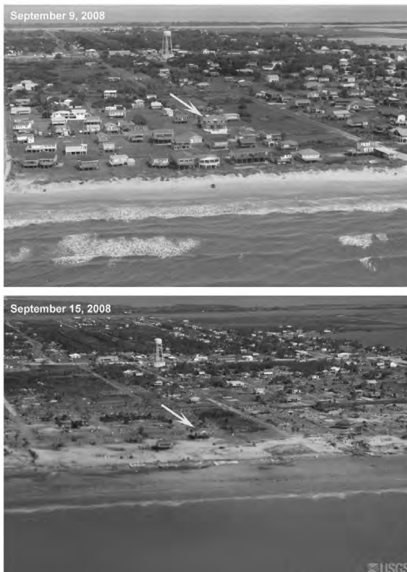
Fot. 1. Stan przed i po przejściu sztormu wzdłuż wybrzeża teksańskiego
