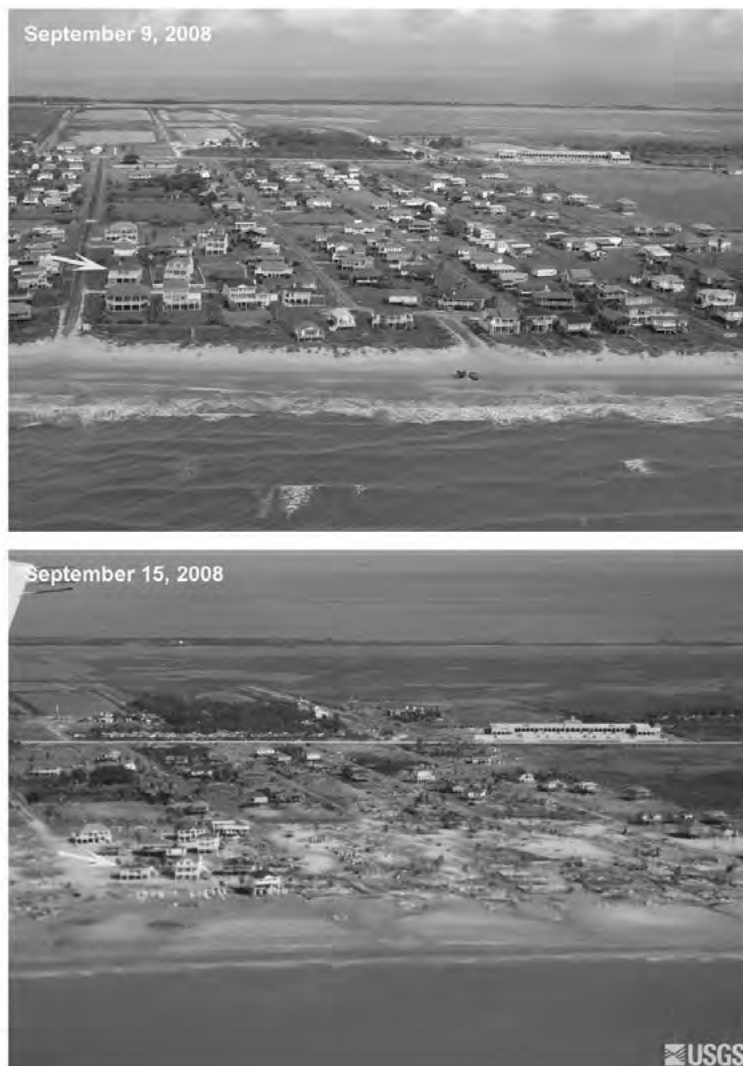
Fot. 3. Stan przed i po przejściu sztormu wzdłuż wybrzeża teksańskiego
