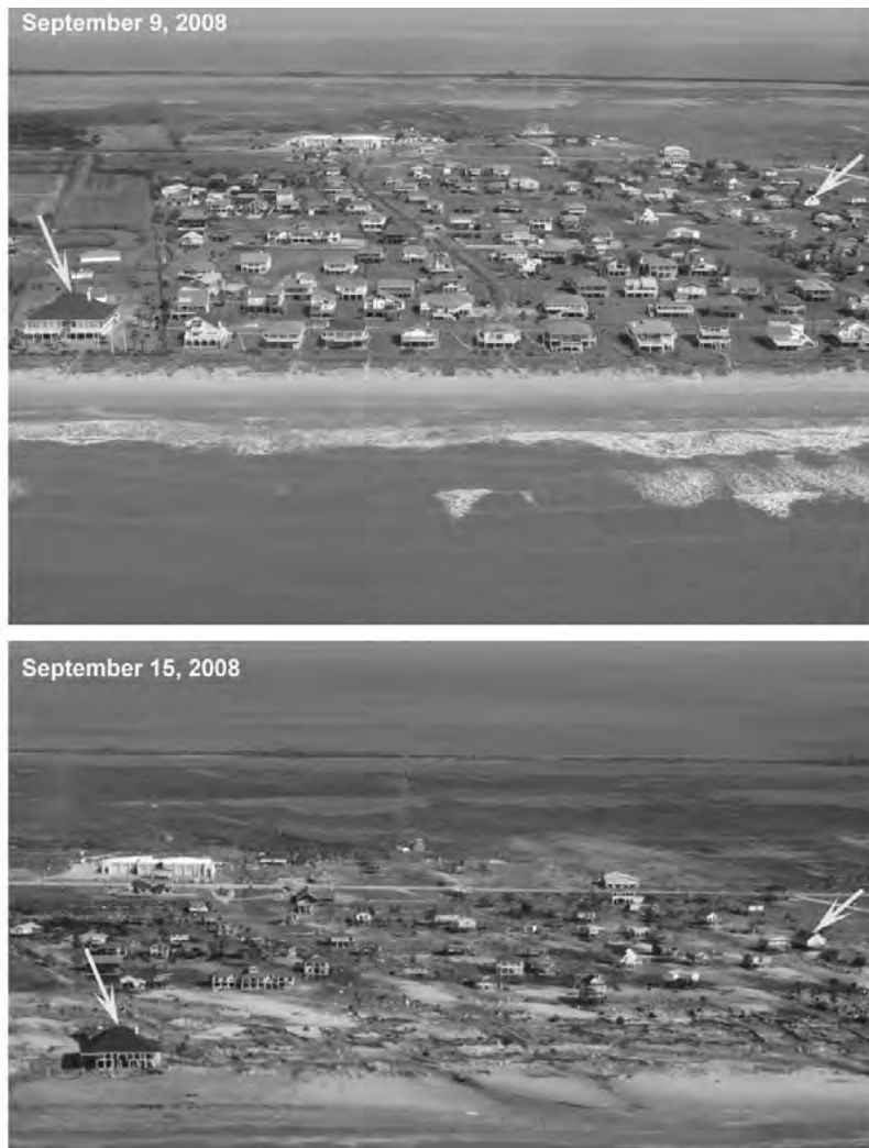
Fot. 4. Stan przed i po przejściu sztormu wzdłuż wybrzeża teksańskiego
