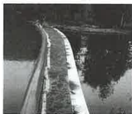
Fot. 2 Zbieranie zanieczyszczeń przed zaporą wodną z użyciem sorpcyjnej wykładziny i sypkiego sorbentu [7]
