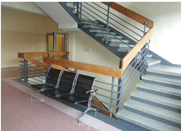
Figure 5. Staircase K1 Rycina 5. Klatka schodowa K1
