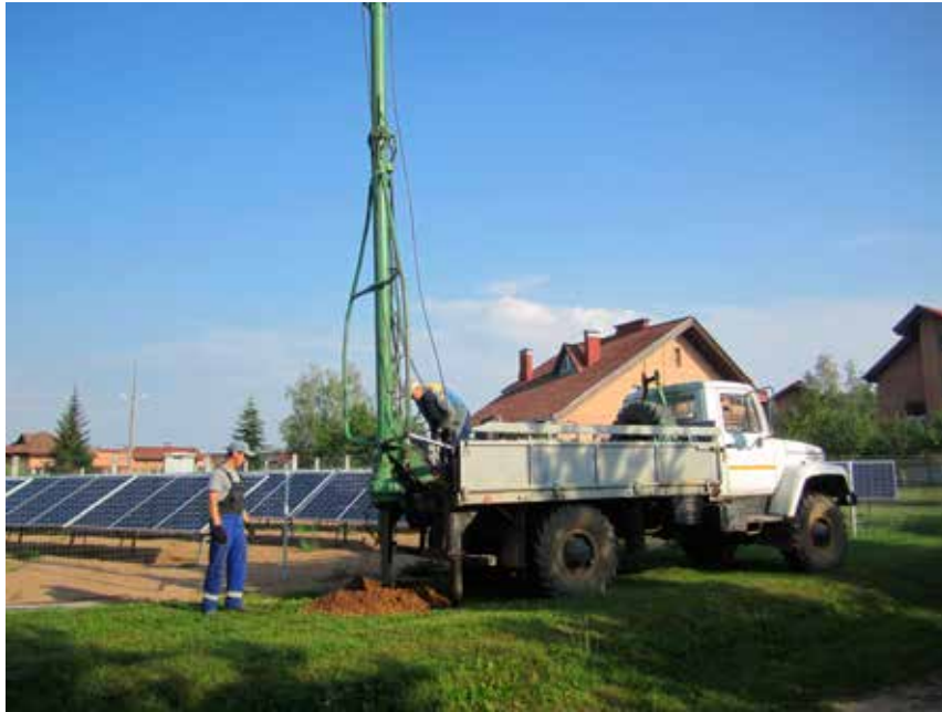
Рис. 4. Бурение скважины для монтажа молниеотвода с повышенными характеристиками устойчивого функционирования на площадке для проведения исследований в д. Боровляны Минского района Fig. 4. Drilling for the installation of a lightning conductor with enhanced resistance level on the testing site in the village of Borovlyany, in Minsk region
