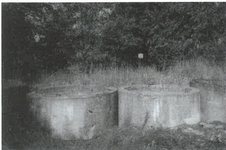
Ryc. 4 Mogilnik w Skorzewie - zbliżenie otwartego zbiornika - na powierzchni szklane opakowania po preparatach pestycydowych [7] fot.. A. Zaleska, listopad 1998 r.
