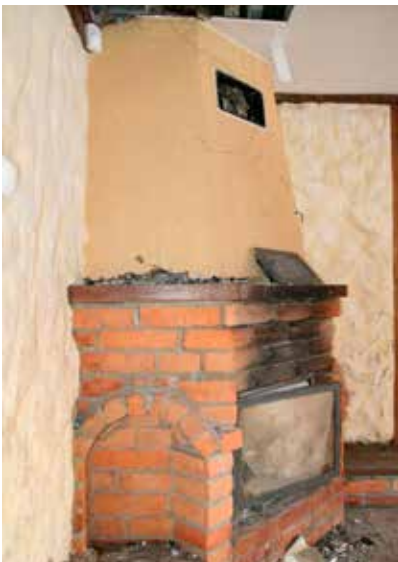
Ryc. 22, 23, 24. Widok kominka z paleniskiem zamkniętym (fot. Tomasz Wiśniewski) Fig. 22, 23, 24. View of the fireplace with closed hearth (photos by Tomasz Wiśniewski)
