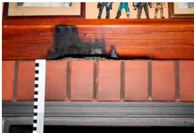
Ryc. 29, 30. Zwęglenia w wyniku pirolizy okapu i czopucha kominka wykonanego ze sklejk (fot. Tomasz Wiśniewski) Fig. 29, 30. Charring caused by pyrolysis of fireplace hood and flue made of plywood (photos by Tomasz Wiśniewski)
