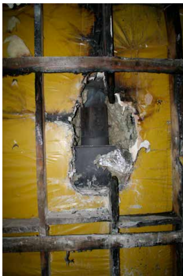
Ryc. 31, 32. Widok kominka, którego ściana tylna została wykonana w konstrukcji szkieletowej z elementów drewnianych a przewody dymowe zostały poprowadzone w odległości 3 cm od tej konstrukcji (fot. Tomasz Wiśniewski) Fig. 31, 32. Picture of a fireplace, whose rear wall frame was constructed from wooden elements and smoke ducts were routed at a distance of 3 cm from this structure (photos by Tomasz Wiśniewski)
