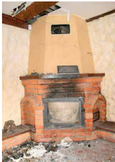
Ryc. 22, 23, 24. Widok kominka z paleniskiem zamkniętym (fot. Tomasz Wiśniewski) Fig. 22, 23, 24. View of the fireplace with closed hearth (photos by Tomasz Wiśniewski)
