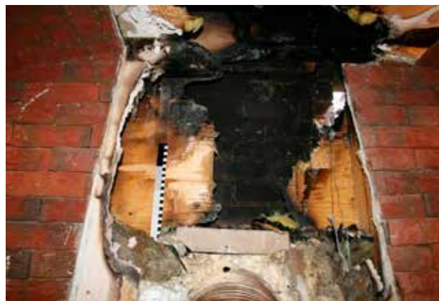
Ryc. 29, 30. Zwęglenia w wyniku pirolizy okapu i czopucha kominka wykonanego ze sklejk (fot. Tomasz Wiśniewski) Fig. 29, 30. Charring caused by pyrolysis of fireplace hood and flue made of plywood (photos by Tomasz Wiśniewski)
