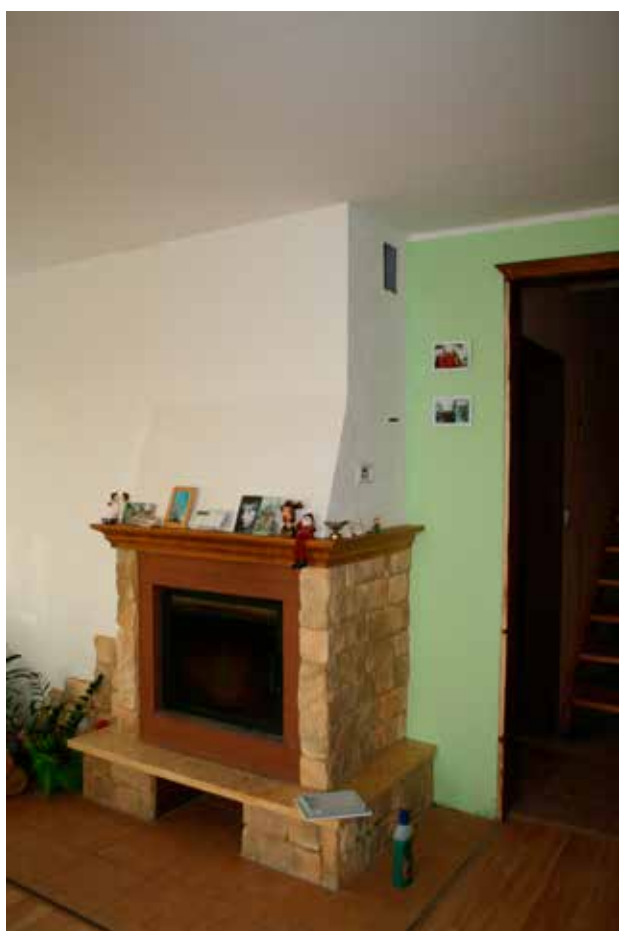
Ryc. 31, 32. Widok kominka, którego ściana tylna została wykonana w konstrukcji szkieletowej z elementów drewnianych a przewody dymowe zostały poprowadzone w odległości 3 cm od tej konstrukcji (fot. Tomasz Wiśniewski) Fig. 31, 32. Picture of a fireplace, whose rear wall frame was constructed from wooden elements and smoke ducts were routed at a distance of 3 cm from this structure (photos by Tomasz Wiśniewski)
