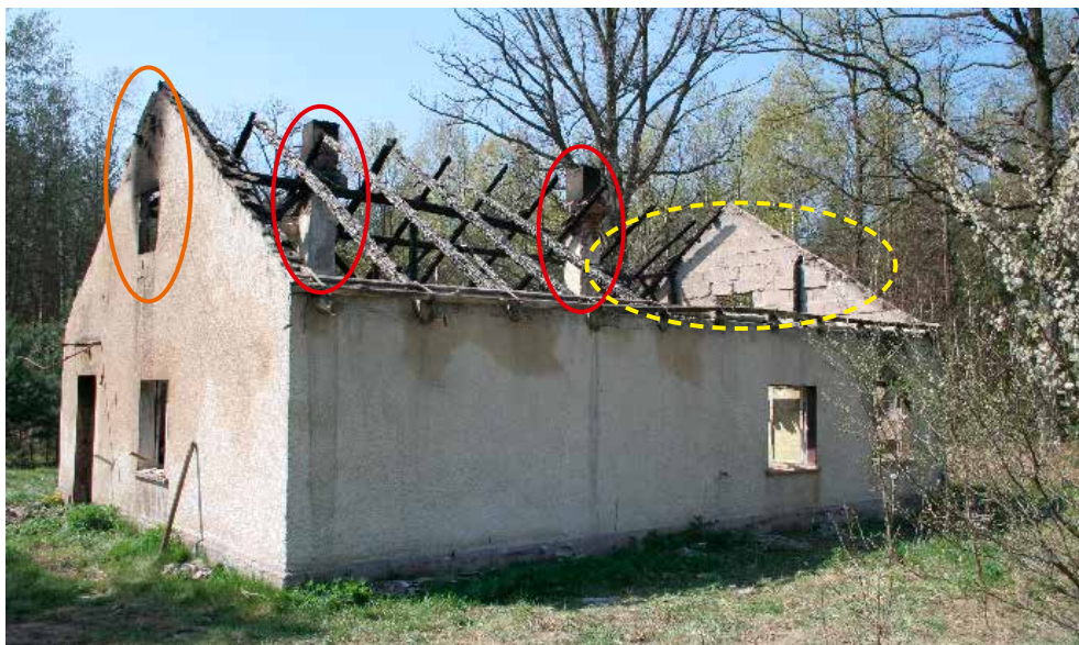
Ryc. 1. Widok domu i jego usytuowania w terenie, wraz z oznaczeniem pomarańczowym owala okna – wydostawania się dymu, czerwonym – nieczynne przewody kominowe oraz zaznaczeniem żółtą obwódką miejsca po pokoju, w którym znaleziono szczątki zwłok ludzkich
