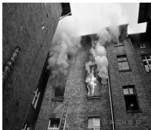
Ryc. 1. Widok okien oficyny przy pl. Grunwaldzkim w Bytomiu w czasie pożaru w dn. 09.06.2010 r. o godz. 5.10 (ze zbiorów Komendy Miejskiej PSP w Bytomiu)
