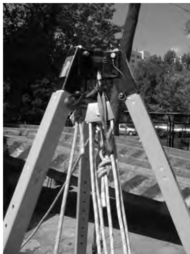
Ryc. 17. Bloker wykonany za pomocą węzła francuskiego
