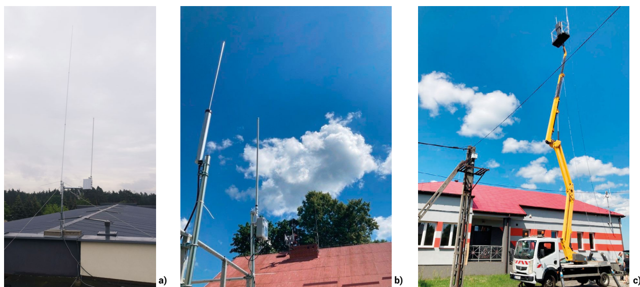
Figure 5. View of antennas: a) base station, b) 4 m mast of the mobile station, c) 19 m lift of the mobile station Rycina 5. Widok anten w: a) stacji bazowej, b) stacji mobilnej maszt 4 m, c) stacji mobilnej
