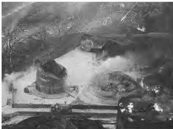
Fot. 4. Skutki pożaru w bazie zbiornikowej
