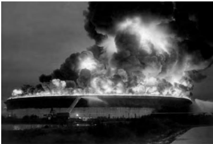
Fot. 1. Pożar zbiornika. Paliwo pali się na całej powierzchni zbiornika.
