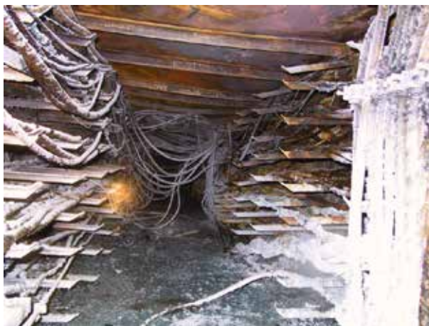
Rycina 10. Skutki pożaru wiązek kabli elektrycznych Figure 10. The impact of fire on electric cable bundles
