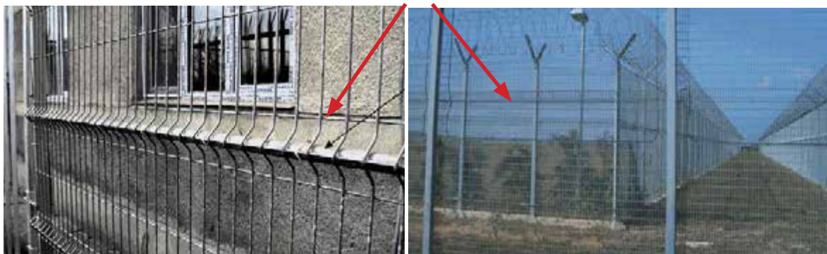
Ryc. 6. Przykładowy sposób instalacji czujnika światłowodowego na ogrodzeniu
