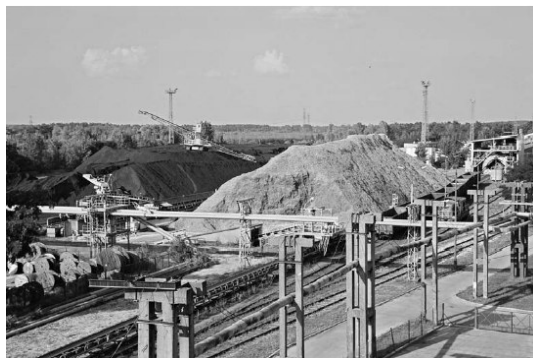
Ryc. 1. Hałda luźnej biomasy przeznaczonej do energetycznego wykorzystania [2]
