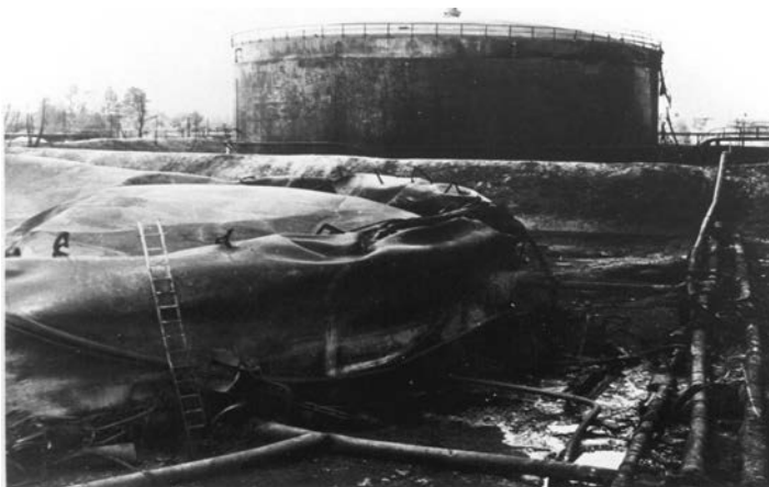
Ryc. 5. Zbiornik po pożarze w rafinerii nafty Czechowice – Dziedzice.
